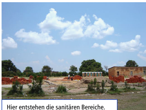
Hier entstehen die sanitären Bereiche.
